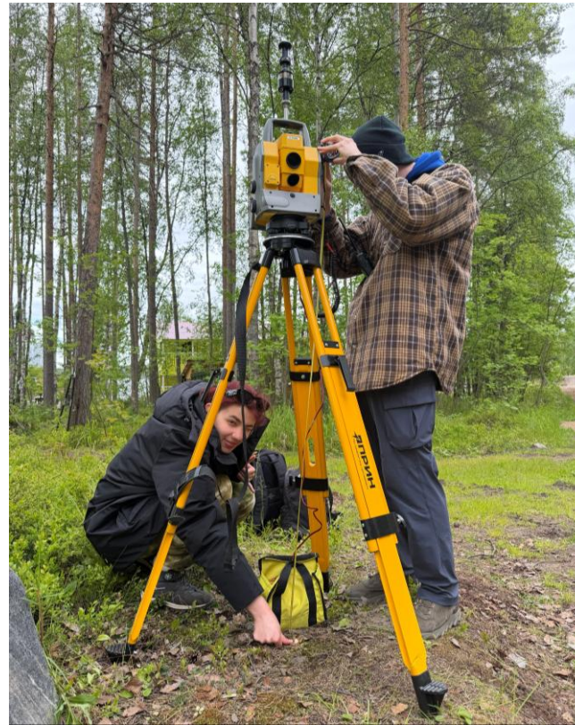
Съёмка: установка прибора
